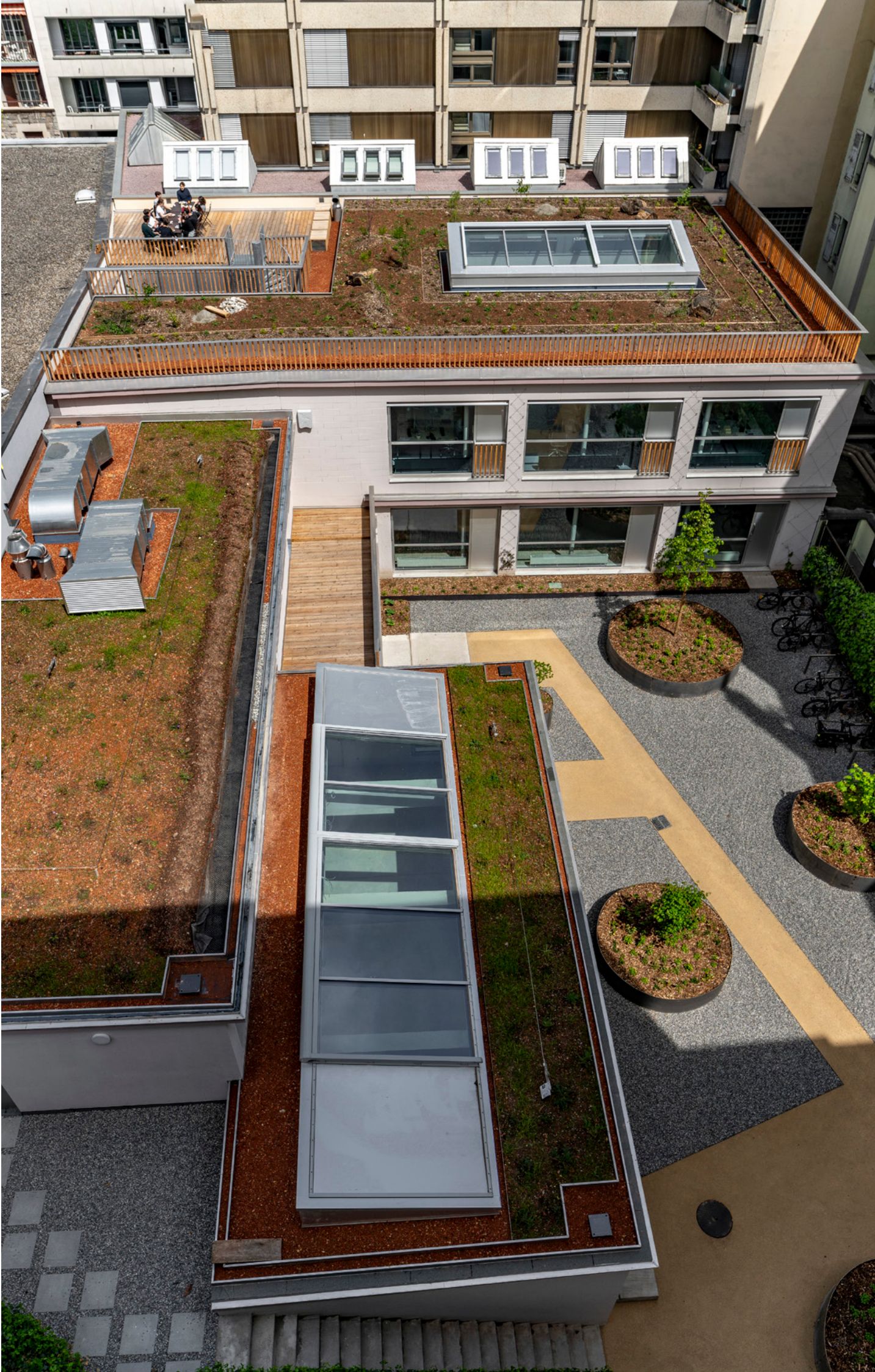
Végétalisation de la cour située au 11 rue Alcide-Jentzer 11 – propriété de la Caisse
