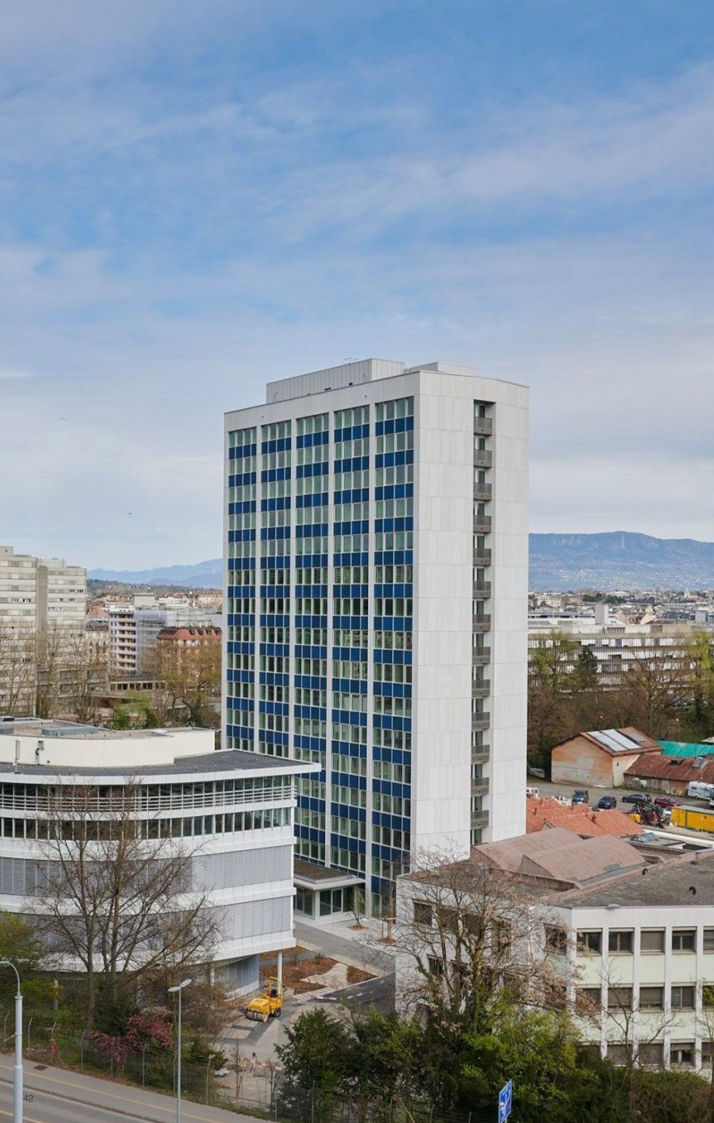
Tour Firmenich, Genève – propriété de la Caisse
