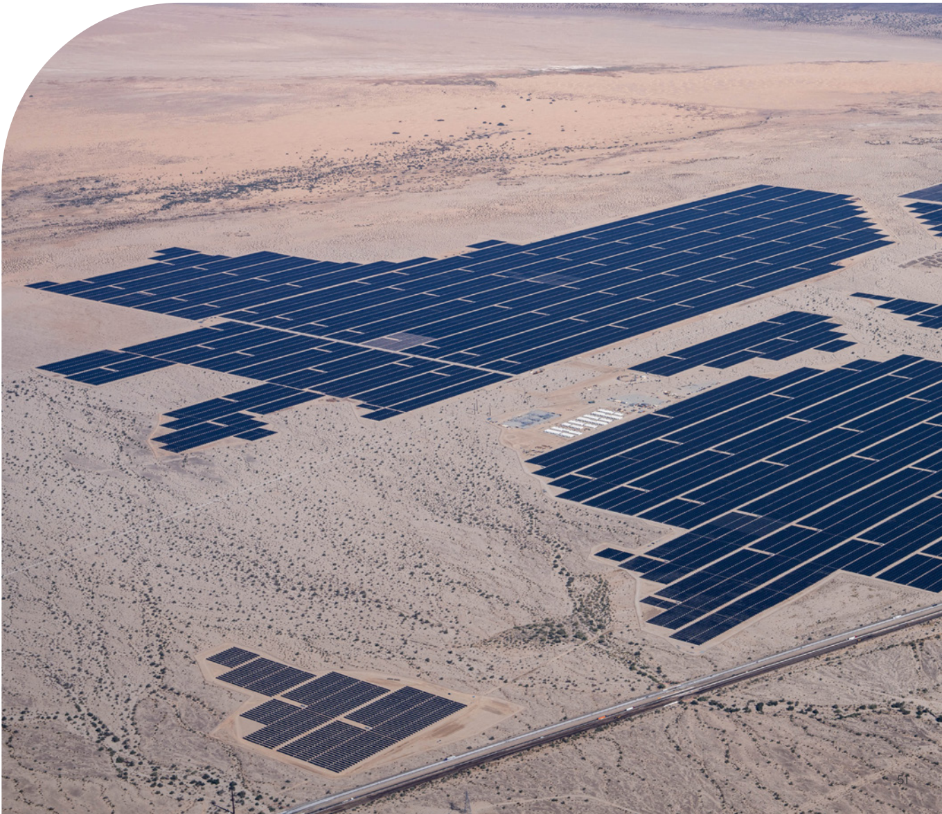
Système de stockage d'énergie combiné à un parc photovoltaïque Riverside County, Etats-Unis - investissement effectué à travers AIP Infrastructure II
