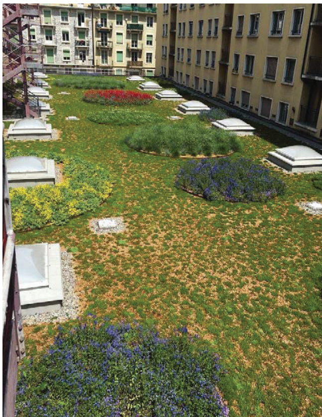
Dans la cour située entre la rue de la Ferme et la rue de la Colline, nous avons végétalisé et fleuri les toitures des entrepôts.
