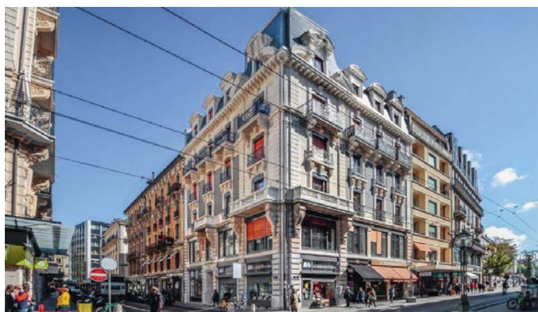
L'immeuble de Tour-Maîtresse 9 dans sa nouvelle livrée gris ardoise, qui forme un contraste tonique avec le vermillon des nouveaux stores en bois. DR
