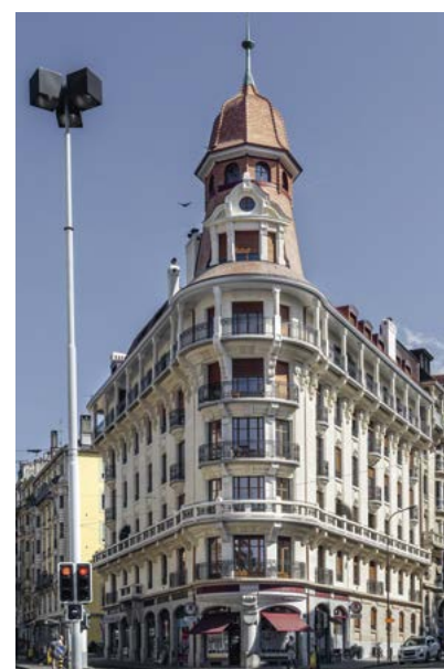
Sur la tourelle emblématique de la route de Chêne 2, les tuiles ont été refaites une à une... C'est reparti pour 100 ans! DR
