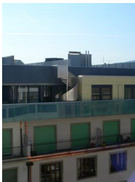
Jean-Jaquet 16 : travaux terminés fin juin 2008
