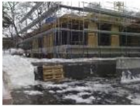
Avancement général à fin octobre 2009 : murs des sous-sols terminés, exécution des dalles niveau rez en cours.
