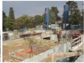
Avancement général à fin octobre 2009 : murs des sous-sols terminés, exécution des dalles niveau rez en cours.
