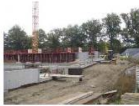
Avancement général à fin octobre 2009 : murs des sous-sols terminés, exécution des dalles niveau rez en cours.
